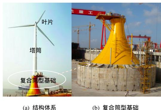
图 1 风力发电结构
